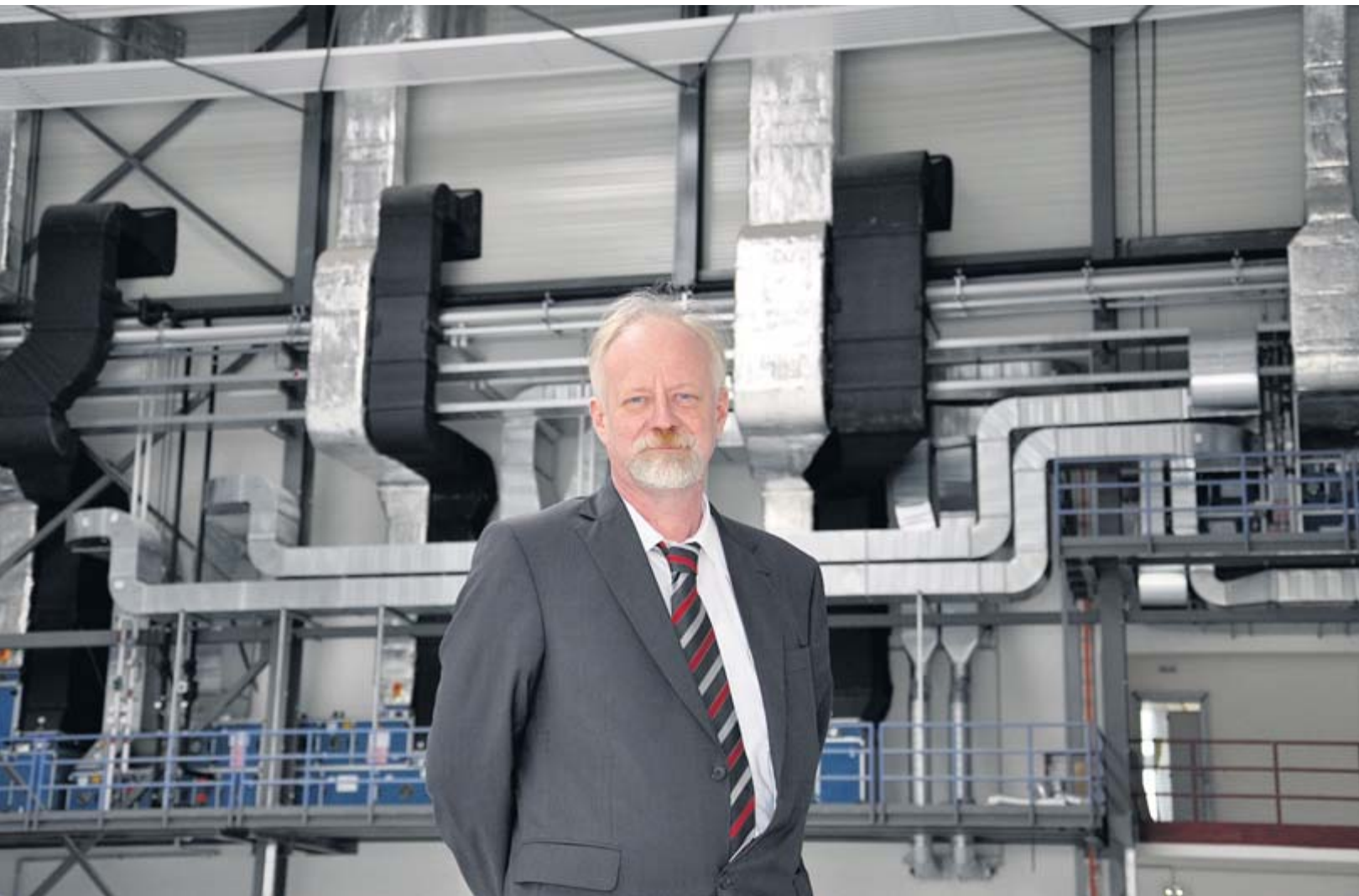
Bernhard Bahlmann ist Projektleiter bei Premium Aerotec für das Technologiezentrum. Im Hintergrund sind Teile der Lüftungsanlage in einer der beiden Werkhallen des TZN zu sehen. Foto: hes
