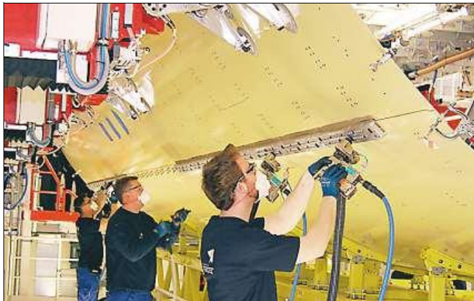
Mitarbeiter von Premium Aerotec bei der Sektionsmontage für den neuen Langstreckenflieger A 350
